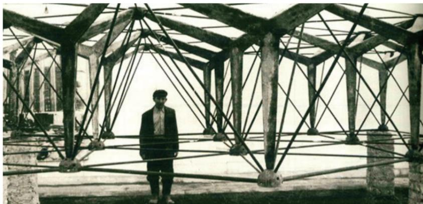
Figura 3. Fotomontaje realizado con los prototipos de módulos tridimensionales de acero que se iban a ensamblar para formalizar la cubierta del pabellón no construido de Polonia.
