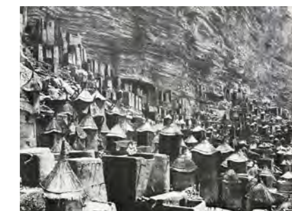
Figura 5. Arquitectura de los dogones. Fuente: Bernard Rudofsky. Arquitectura sin arquitectos (Buenos Aires: Editorial universitaria de Buenos Aires, 1973), 41.
