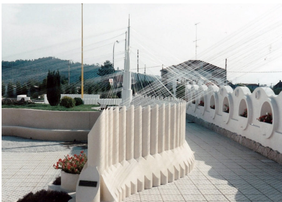
Figura 4. Obra titulada "Tocatta y Fuga", recién construida. Fuente: Vázquez Canónico.
