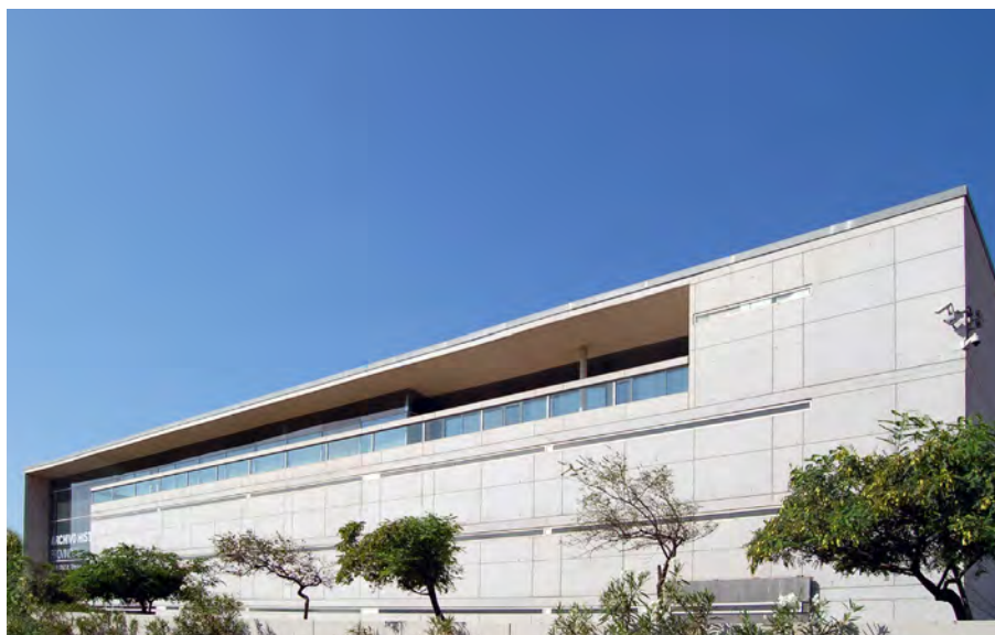
Figura 8. Detalle del lienzo de hormigón y las ventanas rasgadas en la fachada principal del Archivo Histórico Provincial de Santa Cruz de Tenerife, 2003. Fuente: Material del archivo profesional cedido por el arquitecto.
