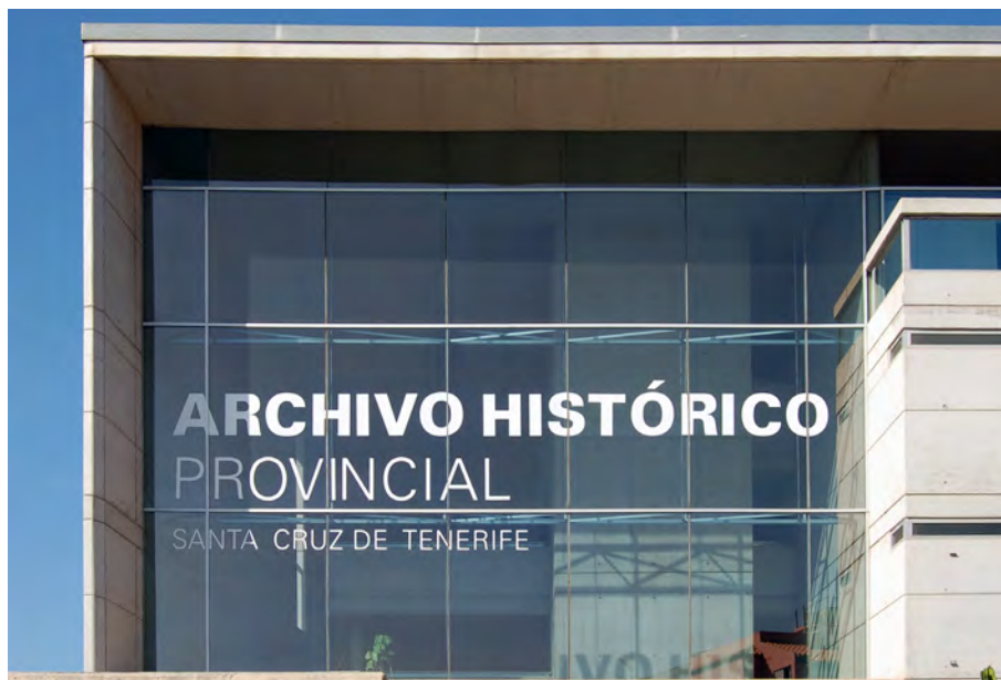
Figura 9. Fachada y muro cortina, Archivo Histórico Provincial de Santa Cruz de Tenerife, 2003. Fuente: Material del archivo profesional cedido por el arquitecto.
