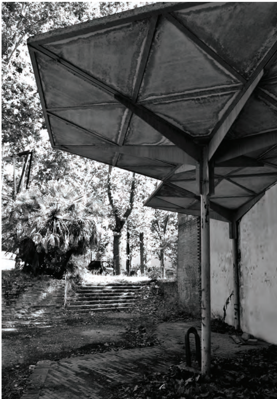
Figura 1. Fotografía del estado de abandono y deterioro del pabellón español reubicado en el recinto ferial de Madrid. Visita no autorizada, captura realizada por el autor en junio de 2014.
